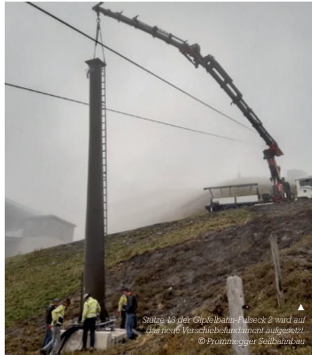
Stütze 13 der Gipfelbahn-Fulseck 2 wird auf das neue Verschiebefundament aufgesetzt.
